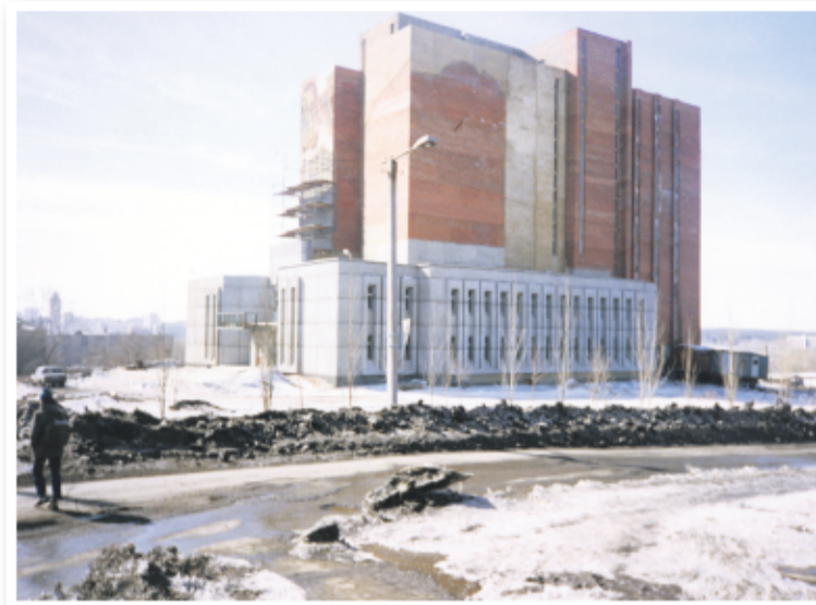
Строительство здания Государственного архива Челябинской области. 1990-е годы
